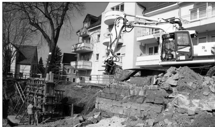
In der letzten Aprilwoche wird das vierte und letzte Element der Stützwand aus Beton gegossen. Erst danach erfolgt der Ständeraufbau. Die Maßnahme liegt im Zeitplan. Zum Stadtfest soll der Dammweg interimsmäßig geöffnet werden.
