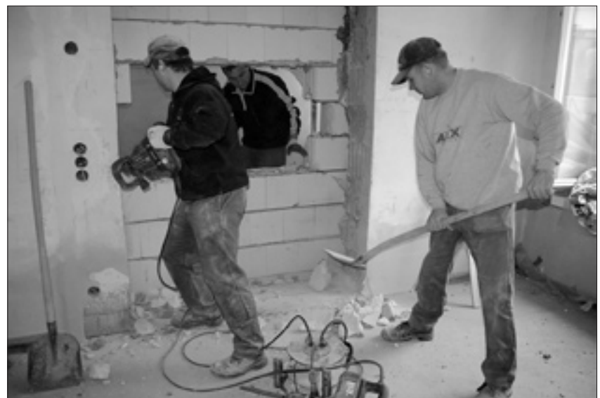
Vorsichtig und ohne viel Schaden erfolgte der Durchbruch zum Haus des Gastes.
